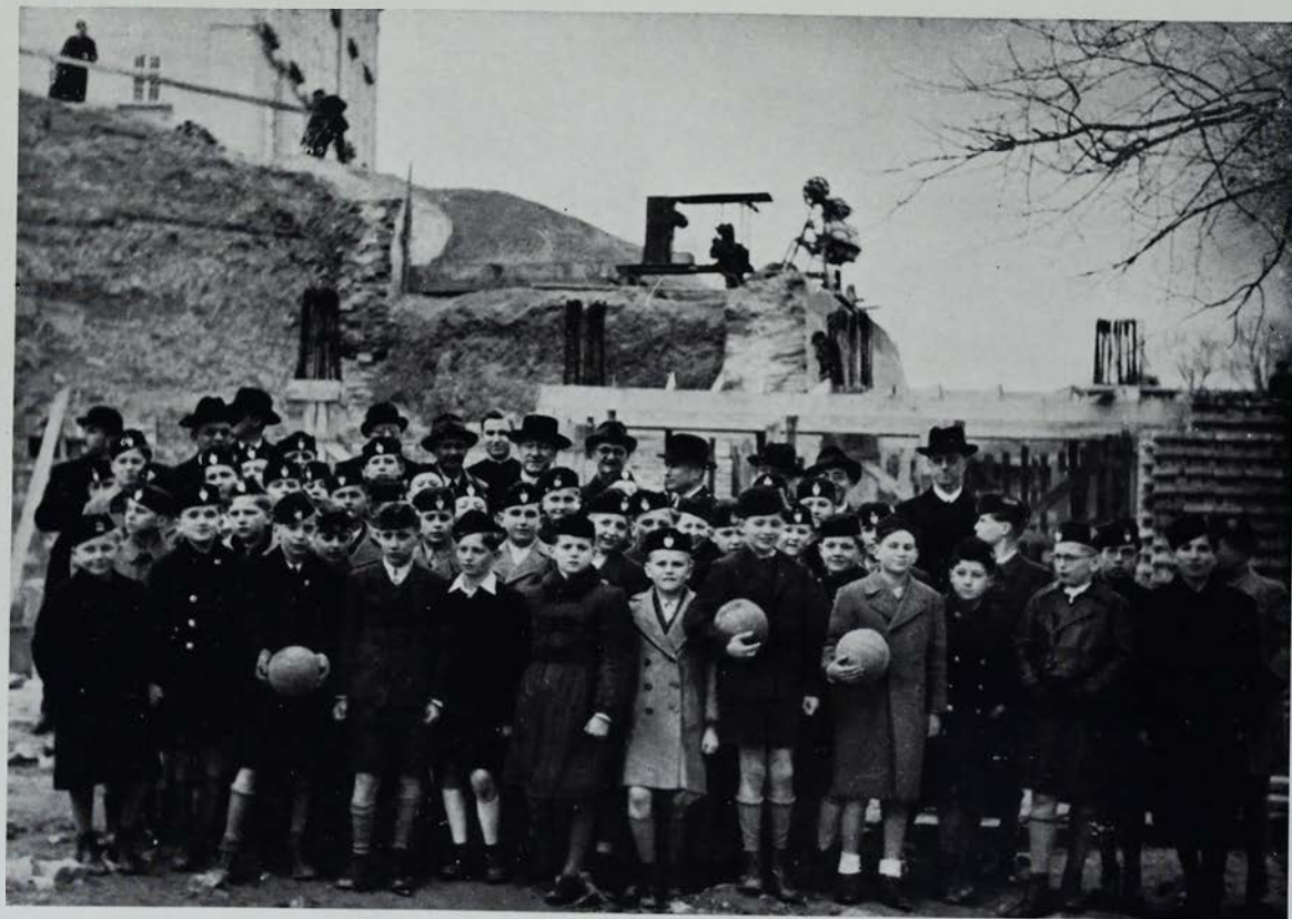
Báró Apor Vilmos győri megyéspüspök úr megtekinti az épülő intézetet.
